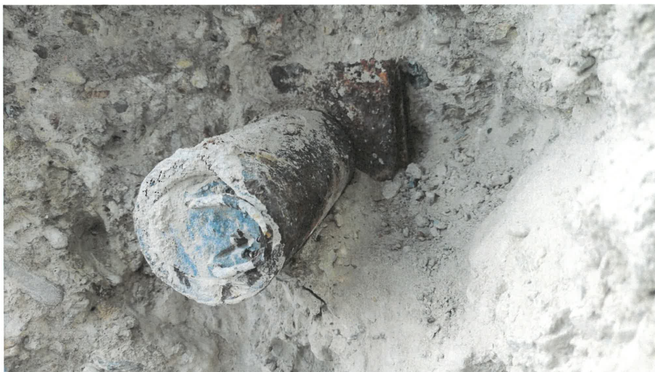
Obr. 5: Detail obnažené kotevní oblasti v místě zkušební plochy Z1. Další fotodokumentace kotevní oblasti byla zařazena do Přílohy č. 2, viz Obr. 1 až Obr. 8.
