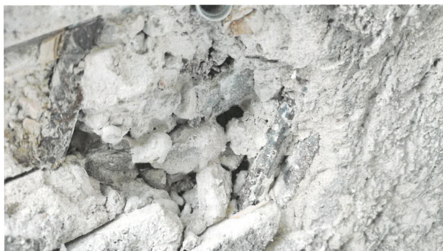
Obr. 11: Ve spodní části zkušební plochy bylo zjištěno šterkové hnízdo.
