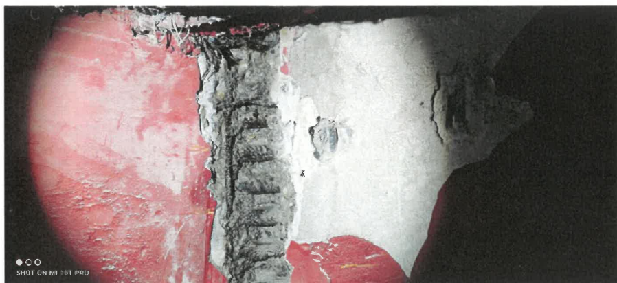
Obr. 19: Sekaná sonda SS1 na vnitřním líci ŽB věnce.
