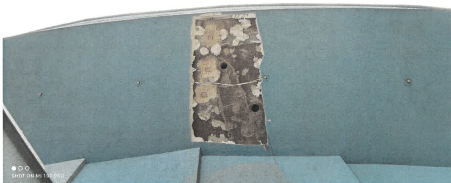
Obr. 13: Pohled na zkušební plochu Z2, která byla provedená na spodním (zešíkmeném) líci ŽB věnce.
