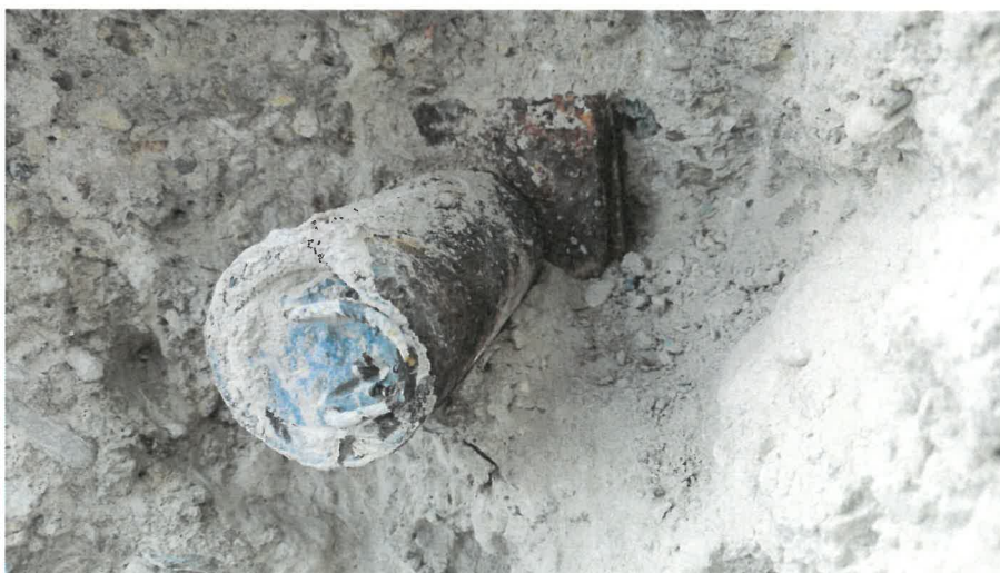
Obr. 2: Detail obnažené kotevní oblasti v místě zkušební plochy Z1.
