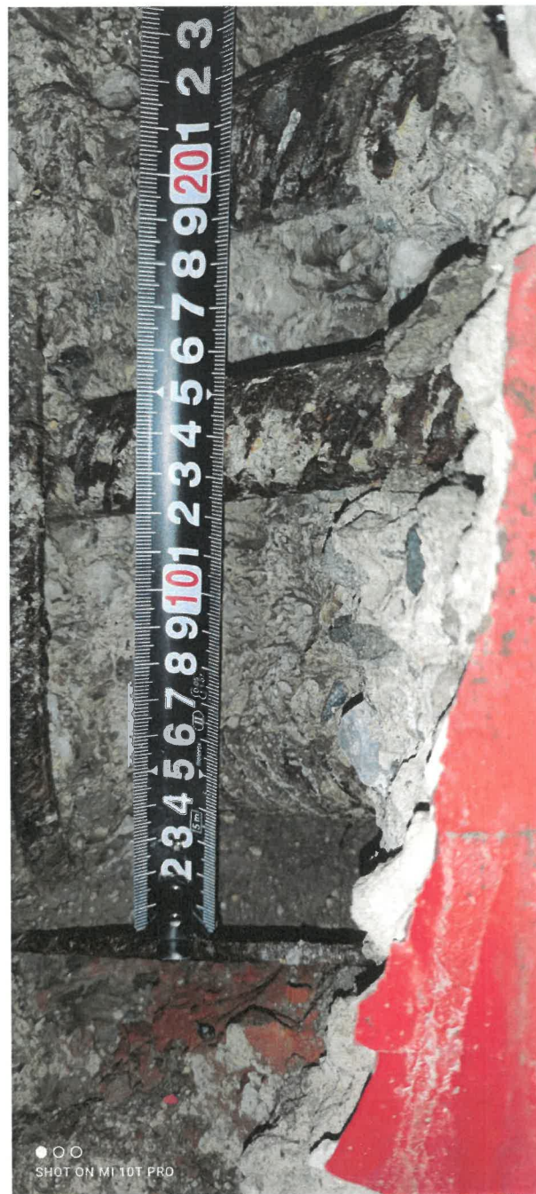
Obr. 20: Detail sekané sondy SS1 na vnitřním líci ŽB věnce.
