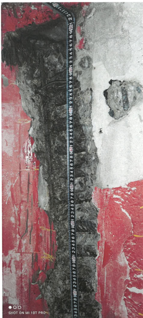
Obr. 20: Detail sekané sondy SS1 na vnitřním líci ŽB věnce.
