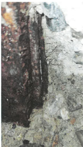
Obr. 5: Obnažená kotevní deska je složena ze 3 ks tenčích desek.
