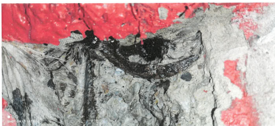
Obr. 22: Detail horní části sekané sondy SS1 na vnitřním líci ŽB věnce – v úrovni kotevních lan byla zabetonovaná ocelová trouba o průměru cca 150 mm, ze které při dešti vytékala voda (po odstranění vnitřní omítky).
