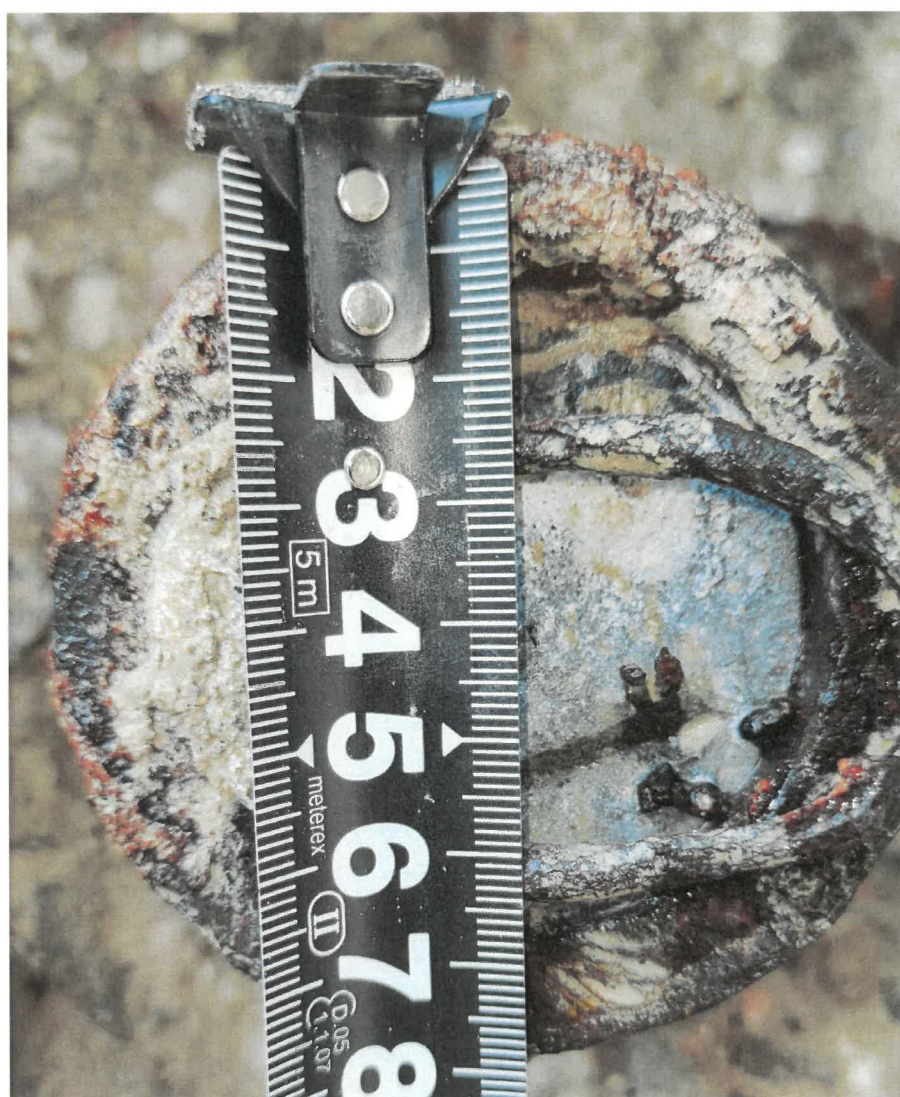
Obr. 4: Detail ukončení obnažené kotevní oblasti v místě zkušební plochy Z1. Tělo je provedeno z ocelové trouby o vnějším průměru cca 80 mm a stěně o tloušťce cca 10 mm.
